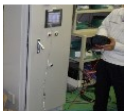
風量制御装置 試運転の様子
